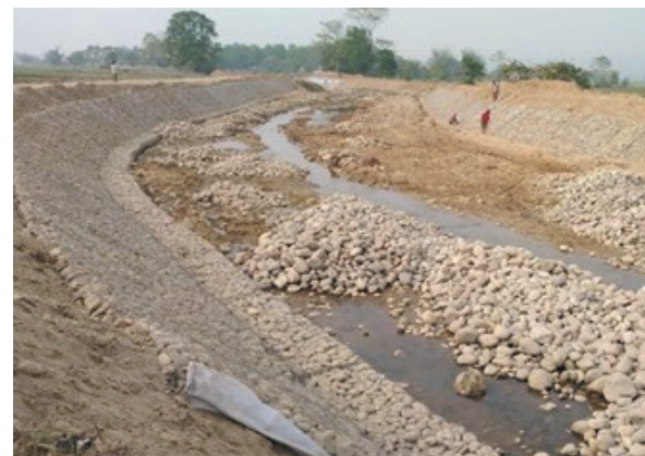
図7：対策前（下流部、川幅の拡張と土堤整備、一部付帯護岸工事）
