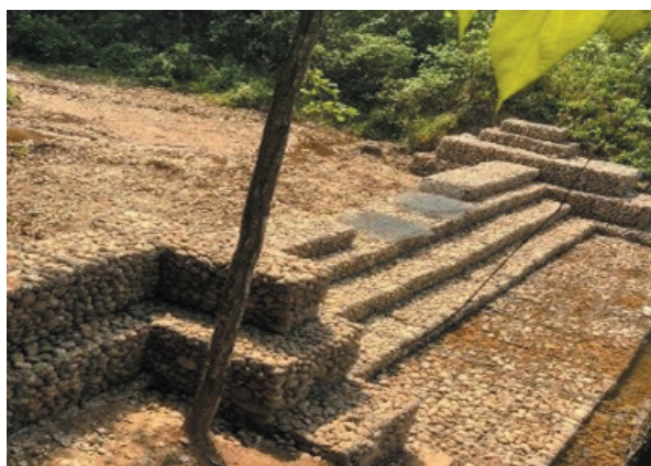
図6：対策後（上流部、防砂ダム）
