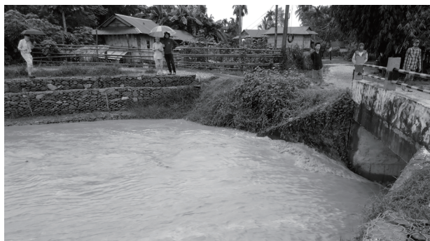
水かさが増した対象河川。土砂とともに勢いよく水が流れる（2024 年 9 月）
