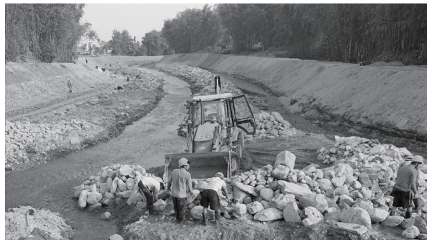
水の流量を増やすための拡幅工事と両岸への土堤設置を行った
