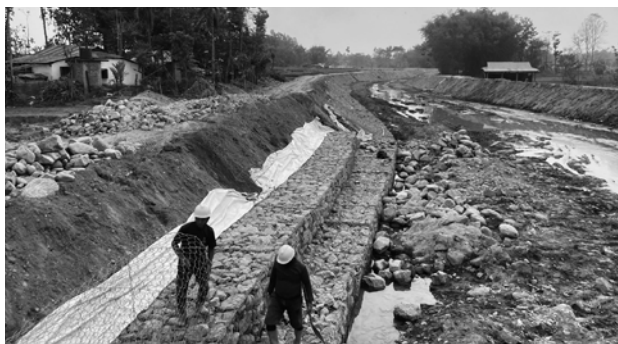
洪水を防ぐためのインフラ工事（土堤造成と護岸）
