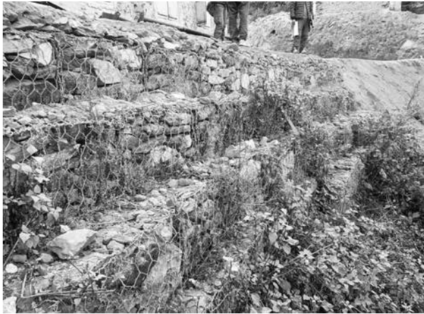
学校の急斜面に設置された土砂崩れ防止壁
