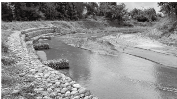
地域住民が維持管理を行う河川。川の蛇行箇所には蛇かごを設置している
